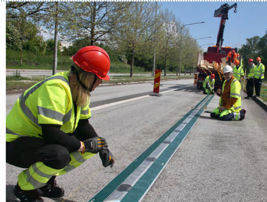
Elonroad testar tekniken i Lund där kollektivtrafiken med elbussar kan vinna stora klimat- och energibesparingar med elvägar. Foto: Elonroad
